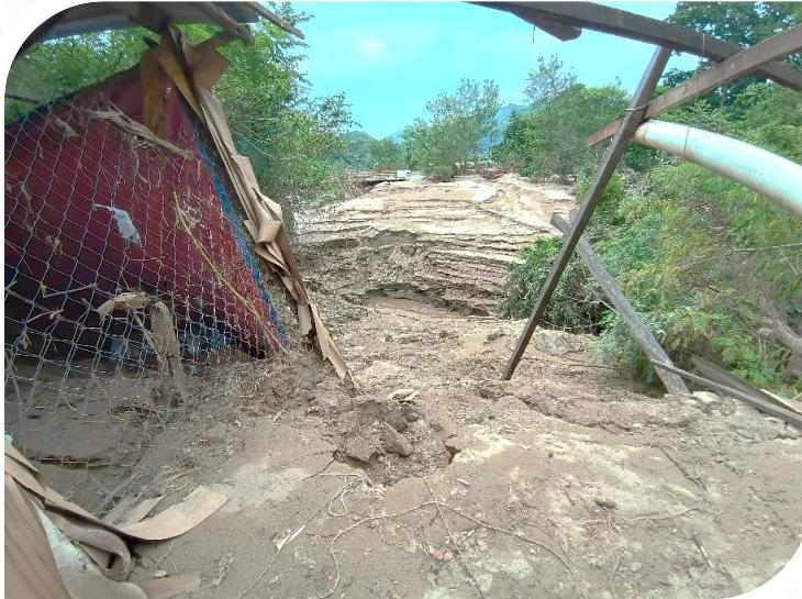
En Papagayo, se realizaron trabajos de desazolve y retiro de derrumbes en 780 metros lineales, eliminando aproximadamente 3,915 metros cúbicos de material acumulado por el huracán, con lo que se recuperó la seguridad y accesibilidad de la localidad.
